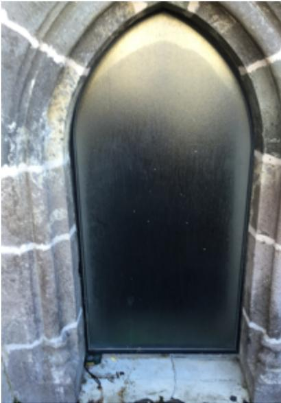
Cette porte a probablement été transformé en fenêtre à l'issue de travaux d'aménagement de la place. Le niveau du sol a été rehaussé, rendant impossible la mesure de la hauteur de cette ouverture. La largeur reste intacte en revanche, et elle mesure  $100\text{ cm} \pm 0,1$ .
